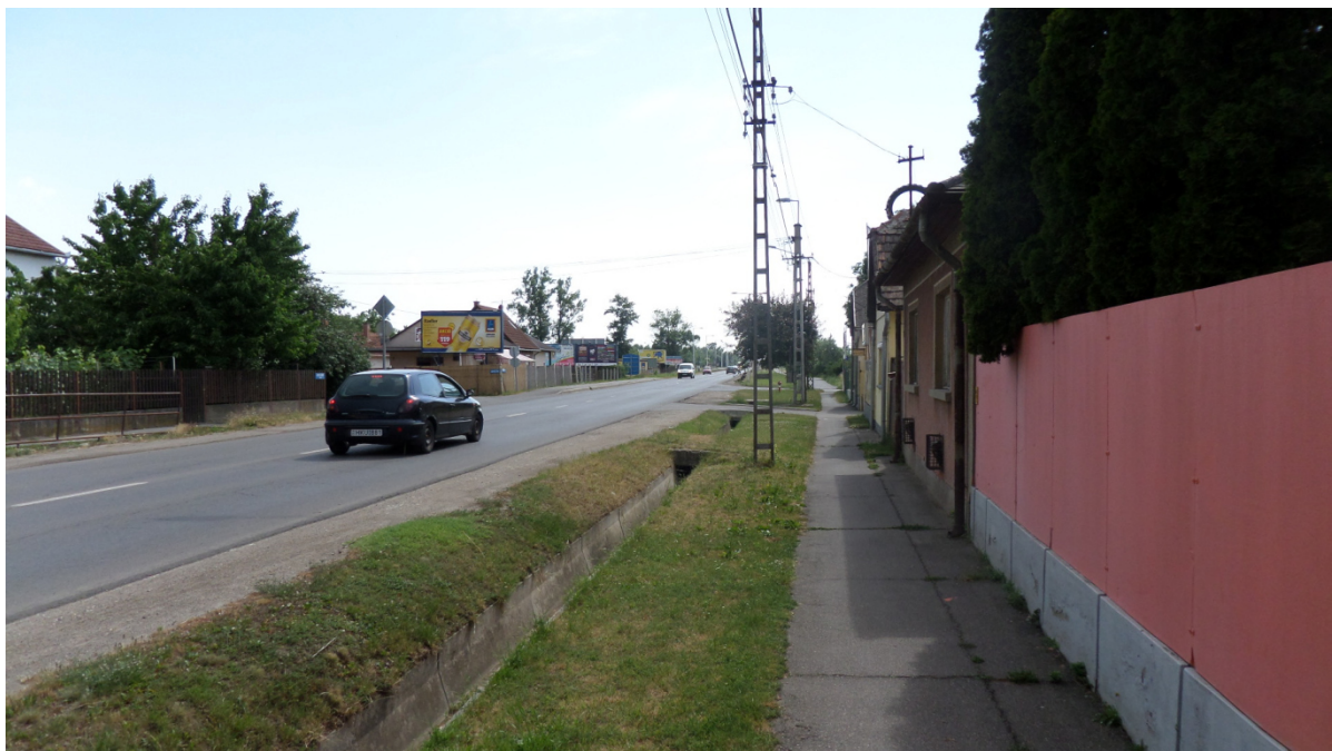
5. kép: Nyílt csapadékvíz elvezetés
