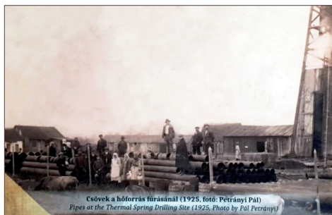
Csővek a hőforrás fúrásnál (1925. foto: Petrányi Pál) Pipes at the Thermal Spring Drilling Site (1925. Photo by Pál Petrányi)
